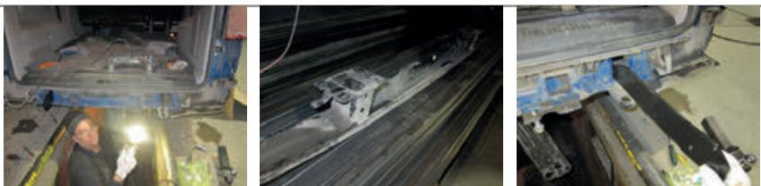
**ШАГ 2.** Совместите отверстия в закладных пластинах и в лонжеронах автомобиля. Наживите закладные пластины болтами M10x1,25x40 к лонжеронам автомобиля через шайбы 10 гроверные и шайбы 10 увеличенные. Соединения не затягивайте .
